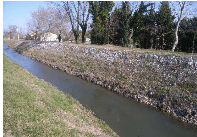
Digues en remblais
