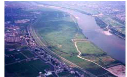
鵜殿ヨシ原の保全再生
