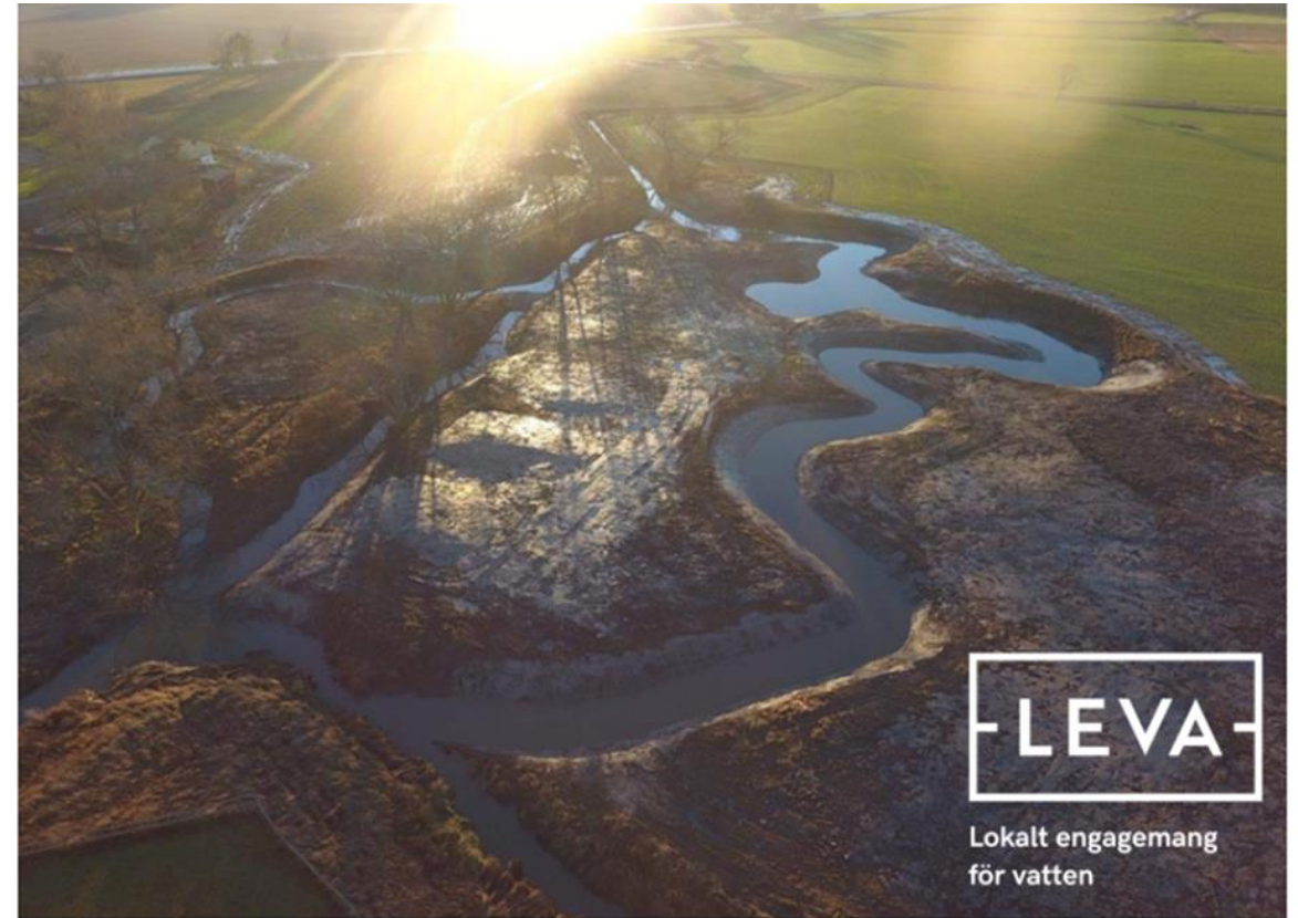
Färdiggrävd våtmark hösten 2020. Foto Edlunds schakt AB
