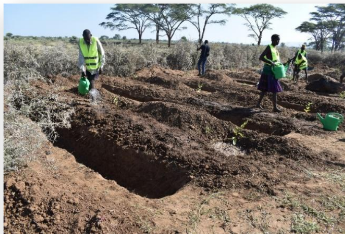
Tranchées d'infiltration au niveau du site du forage d'eau souterraine de Longoloko, Ouganda
