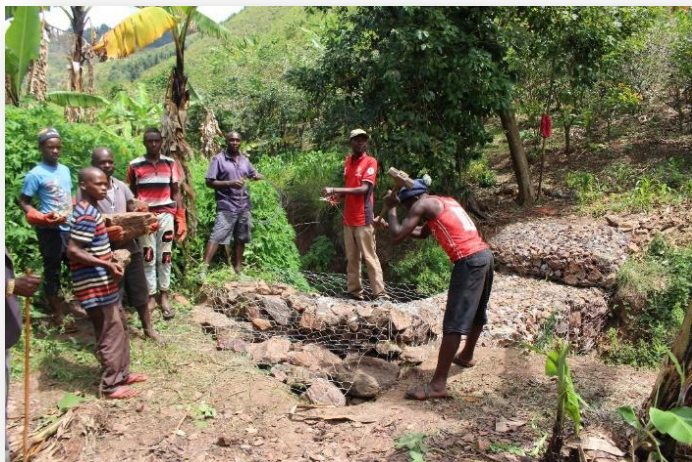
Structures de rétention d'eau, Ouganda
