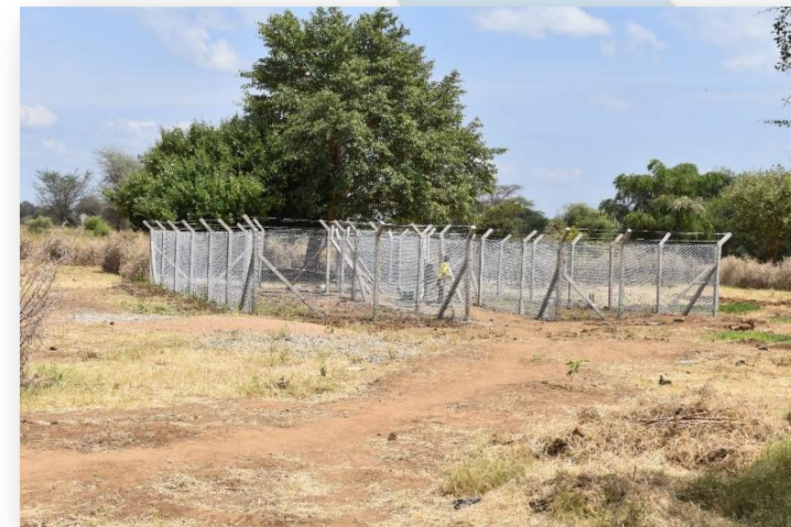
Clôture du site de forage d'eau souterraine de Kokorio, Ouganda
