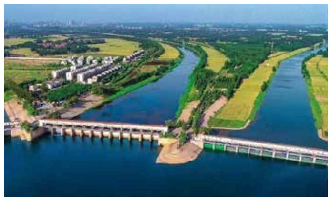
As águas de desvio do rio Yangtze, do rio Amarelo e as entradas do Canal de Wei convergem na junção Si Nü Si. © HWCC
