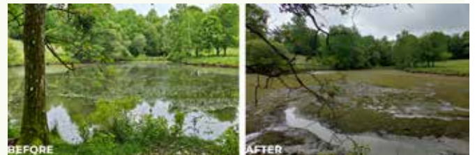
Trabalhos de remoção de lagoas na Bacia da Vienne com o objetivo de reconstituir a continuidade hidrológica © EPTB Vienne
