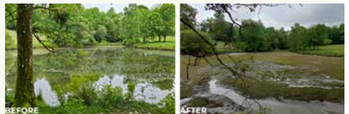
Obras de eliminación de estanques en la cuenca del Vienne con el objetivo de restablecer la continuidad hidrológica © EPTB Vienne
