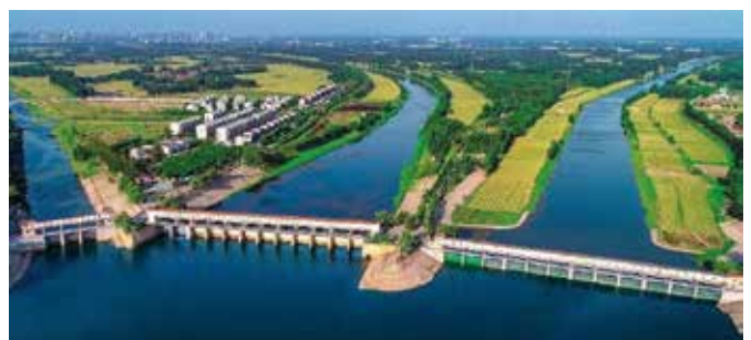
En el cruce Si Nü Si confluyen las aguas de trasvase del río Yangtsé, las aguas de trasvase del río Amarillo y las afluentes del canal Wei. © HWCC
